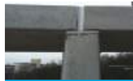
5. JOINT 부위 코킹
