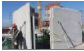
3. Prop 서포트 설치
