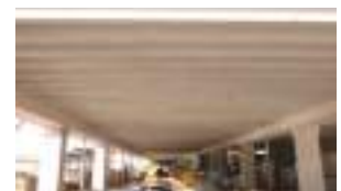
8. 주차장 골조 완성
